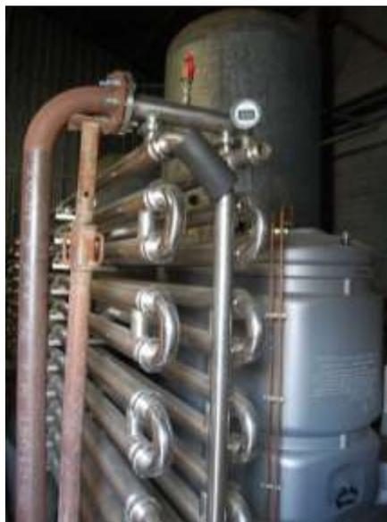
Echangeur tubulaire pour chauffer le moût
